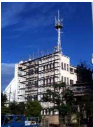
解体のため、足場が組まれた2号館
