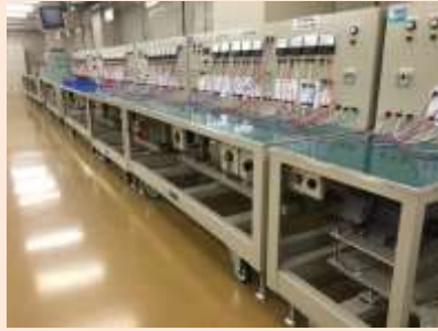
新しい発電機、電動機の機材
